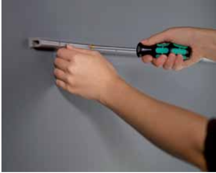
1. Schiene an der Wand befestigen
